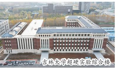
由高新工程公司承建的吉林大学超硬实验综合楼项目位于高端技术开发区前进大街，以实验教学为主要功能及用途。建筑面积19286.1m<sup>2</sup>，层数五层，首层层高5.1m，净跨度为8.1m，最大梁截面尺寸达到300×750mm。屋面玻纤造型，坡度达到了22.35度。
