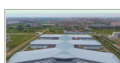
工程名称:航天信息产业园项目一期-生产厂房铝镁锰板屋面制作安装
